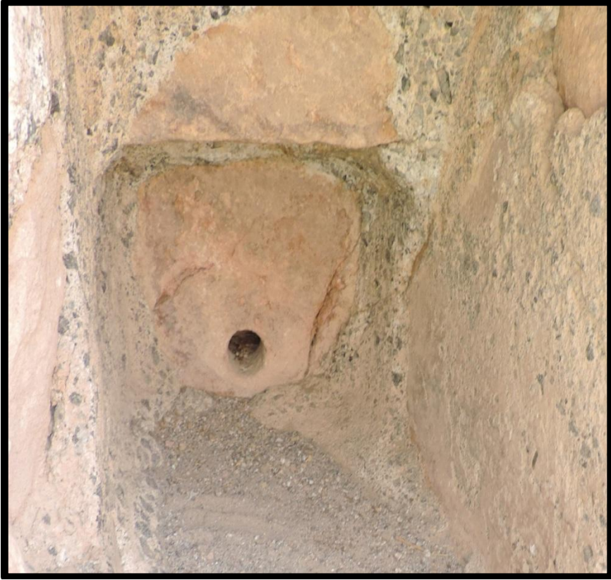
صورة (٦) فتحة خروج الماء - سد أضرعة
