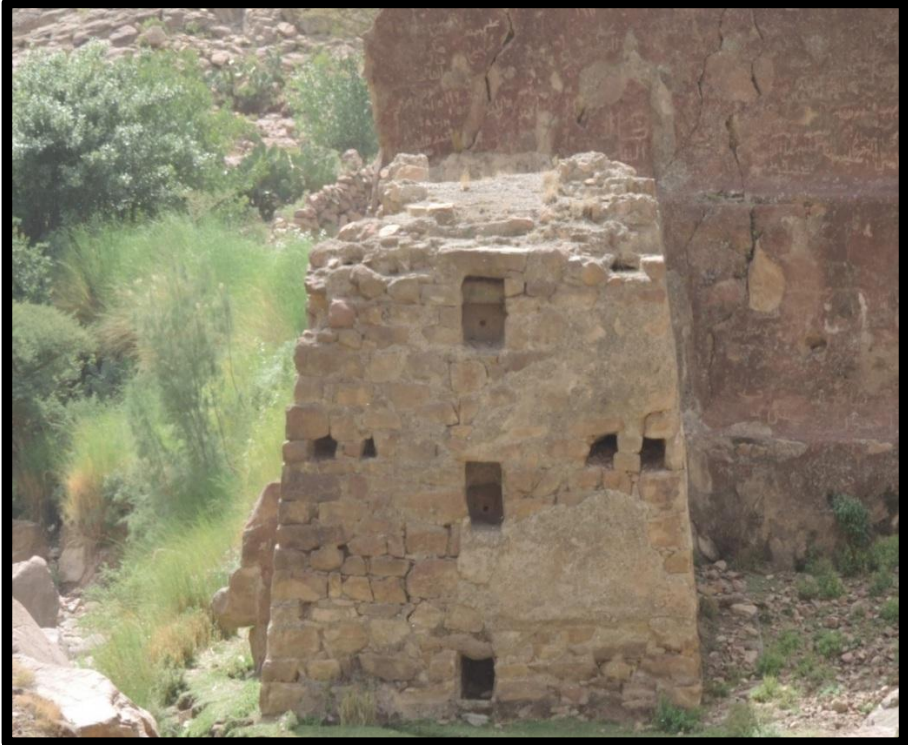
صورة (٥) وحدة التصريف من الداخل وتظهر فتحات خروج الماء.
